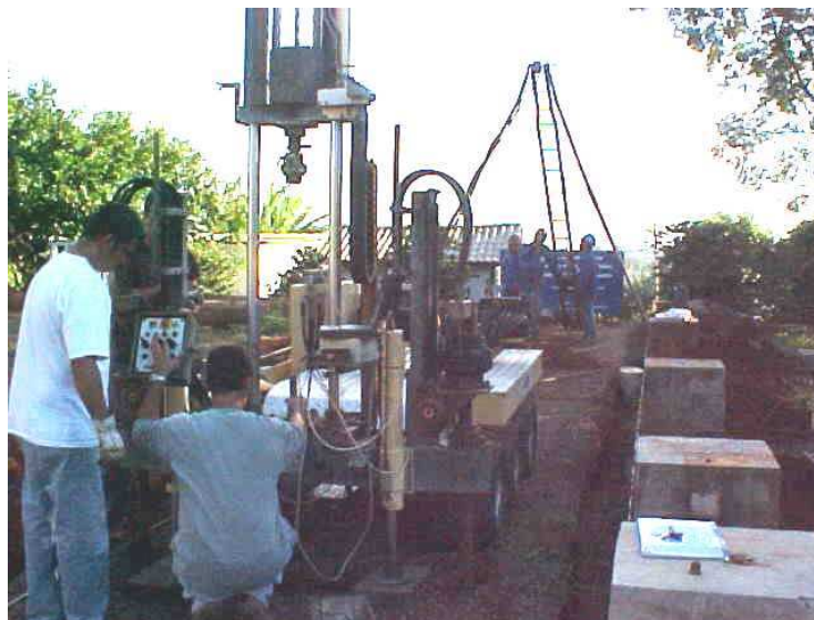
Figura 2.14. Execução do ensaio de cone elétrico no campo experimental da Feagri.
