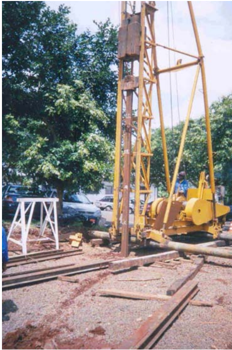
Figura 2.37. Cravação das estacas metálicas.
