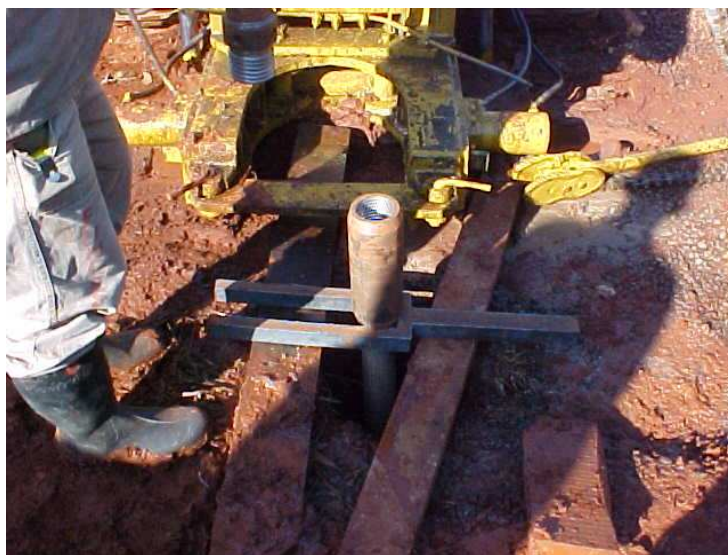
Figura 2.28. Garfo metálico travando a luva na superfície do terreno e mantendo o primeiro segmento do tirante suspenso na escavação do fuste.
