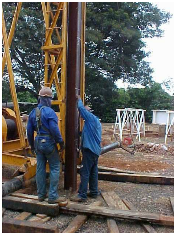
Figura 2.36. Verificação do prumo do perfil metálico.
