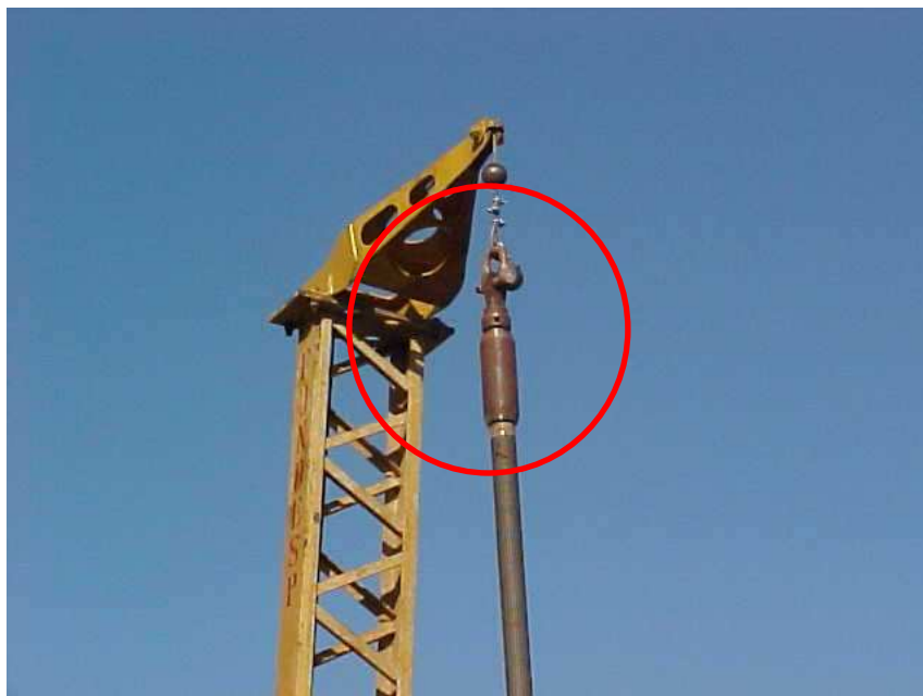
Figura 2.23 - Detalhe da luva especial durante o levante do tirante.
