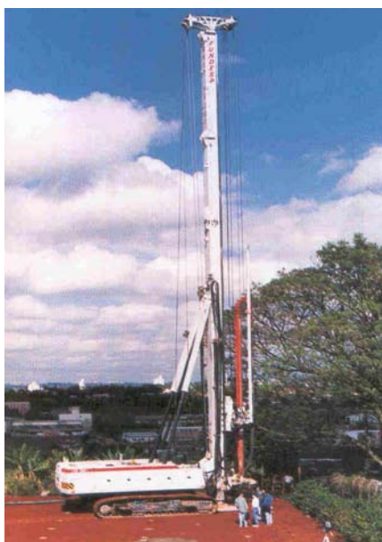
Figura 2.31. Perfuratriz utilizada para execução de estacas hélice contínua e ômega.
