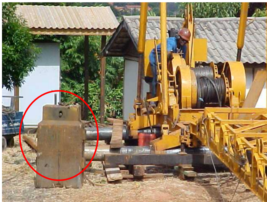
Figura 2.34. Pilão de 1,9 toneladas utilizado.
