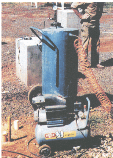
Figura 6.4. Reservatório de nata e compressor de ar.
