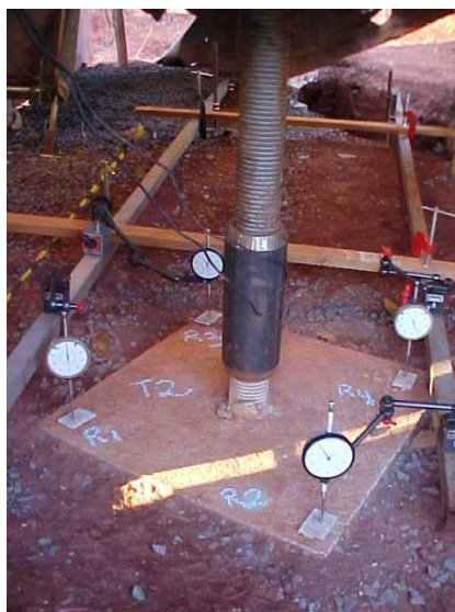
Figura 3.11. Posicionamento dos relógios comparadores sobre bloco de estaca teste tipo raiz.
