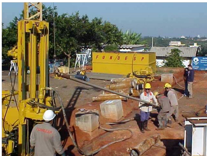
Figura 2.24 - Levantamento de um segmento de tirante de 6m.
