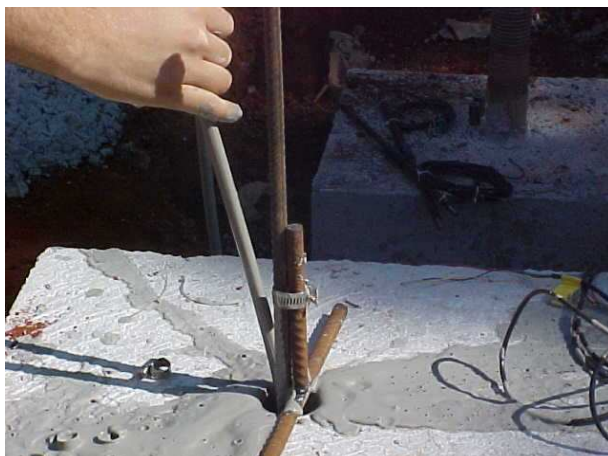
Figura 6.5. Injeção da nata de cimento pela mangueira. Notar que a barra instrumentada permanece suspensa e travada por um “T” metálico para evitar possíveis flambagens.
