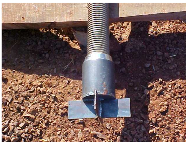
Figura 2.27. Luva com aletas rosqueada na base do tirante.
