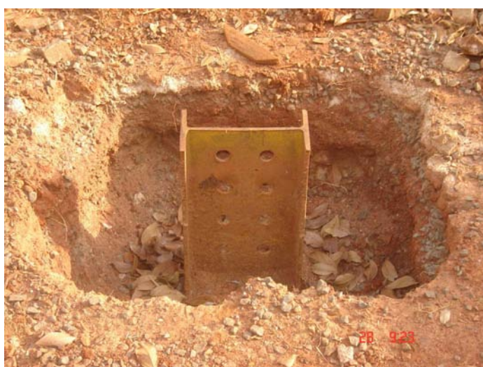
Figura 2.40. Perfil metálico perfurado e cravado.
