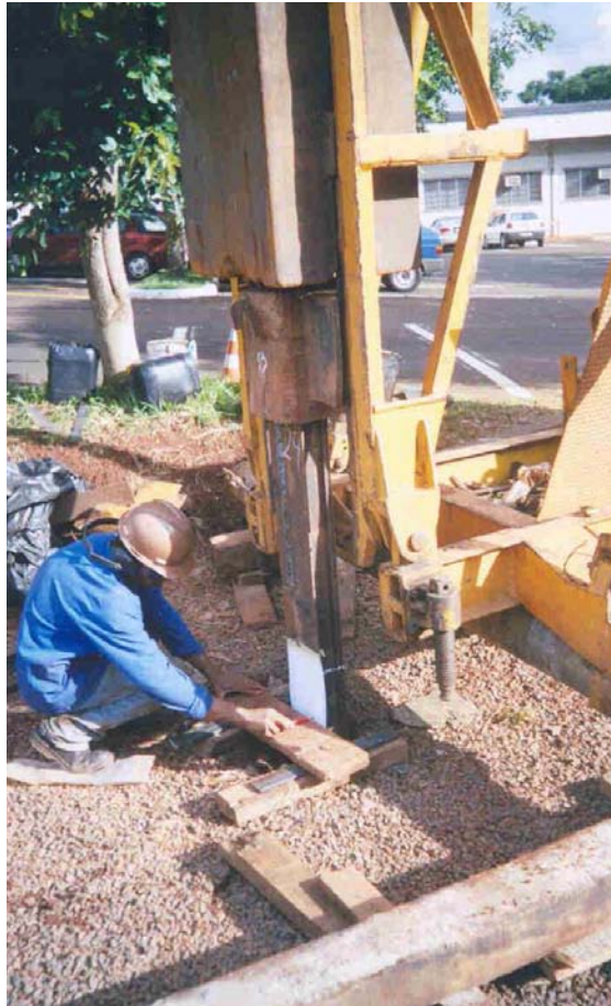
Figura 2.39. Verificação da nega em trilho.
