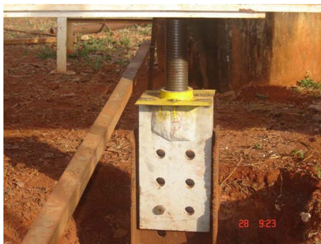
Figura 2.41. Garra metálica acoplada ao perfil metálico.
