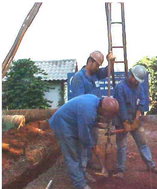
Figura 2.15. Execução da sondagem tipo SPT-T, operação de escavação com trado manual.
