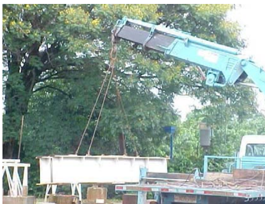
Figura 3.6. Instalação da viga de reação com auxílio de caminhão Munck .
