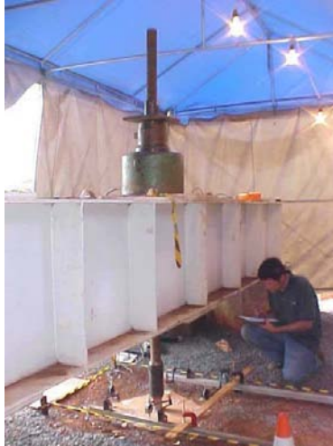
Figura 3.7. Prova de carga executada em estaca raiz.
