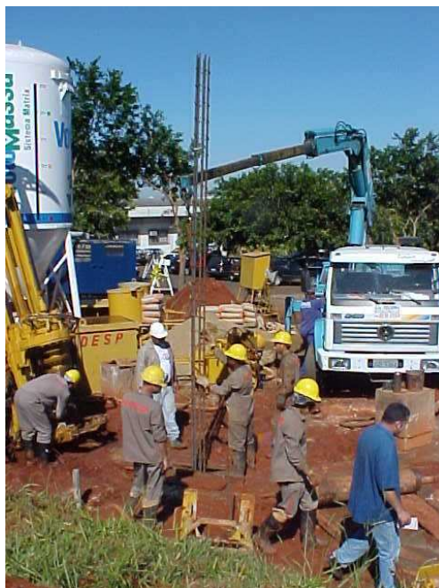
Figura 2.21. Inserção da armadura na escavação.
