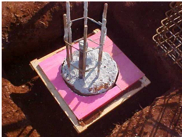
Figura 6.2. Camisa pronta para ser aterrada.
