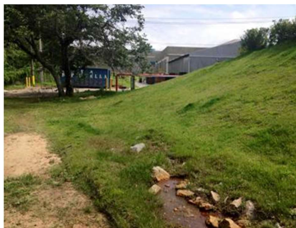
Figura 4. Talude de jusante.
