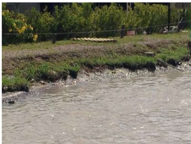
Figura 1. Talude de montante da lagoa revestido com manta PEAD e proteção em enrocamento.
